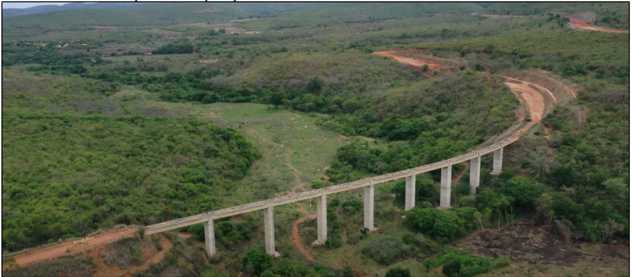
Figura 1 – Ferrovia de Integração Oeste-Leste. Trecho entre Ilhéus e Caetité: obras iniciadas em 2011 e paralisadas pela primeira vez em 2015. Extensão de 537 km.
