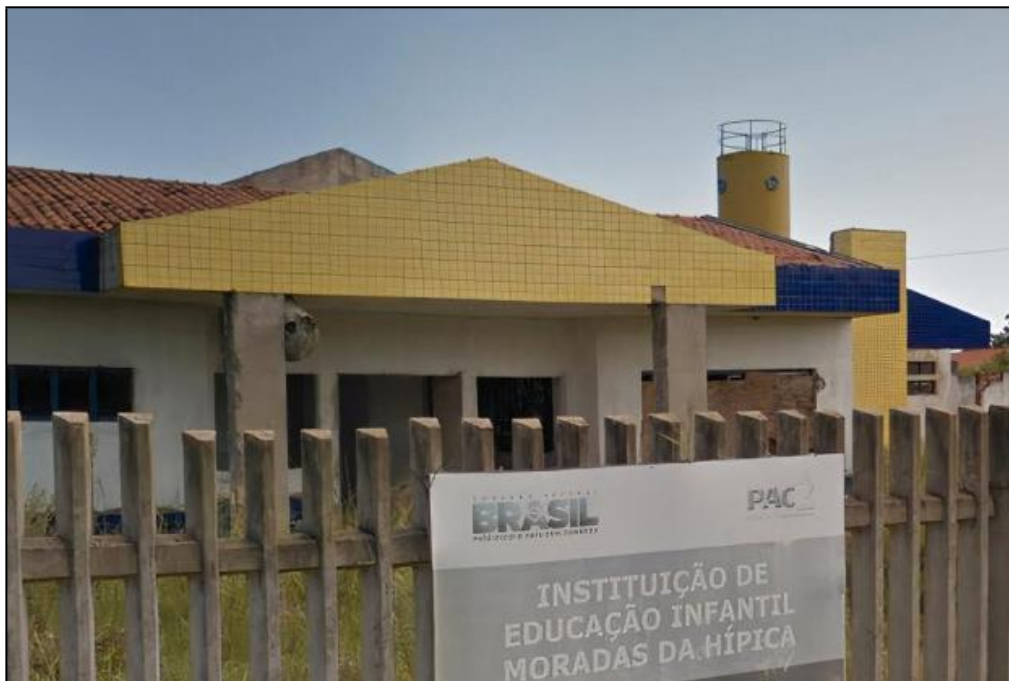
Figura 5 - Escola municipal em zona urbana de Porto Alegre/RS: obra inacabada.
