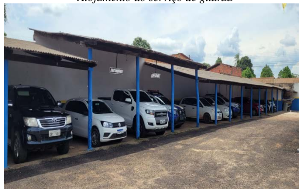
Garagem coberta com nova pintura
