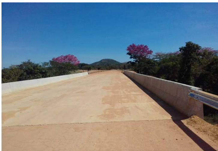
Obra 02 - Ponte sobre o Rio Manoel Alves - TO-482 Entroc. Br-010 (Santa Rosa) / Pov. Apinajés com extensão de 150 m.
