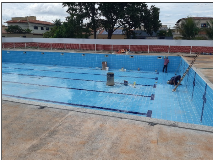
Construção da piscina semiolímpica do CBMTO em Palmas – TO (foto de 02/12/2022).
