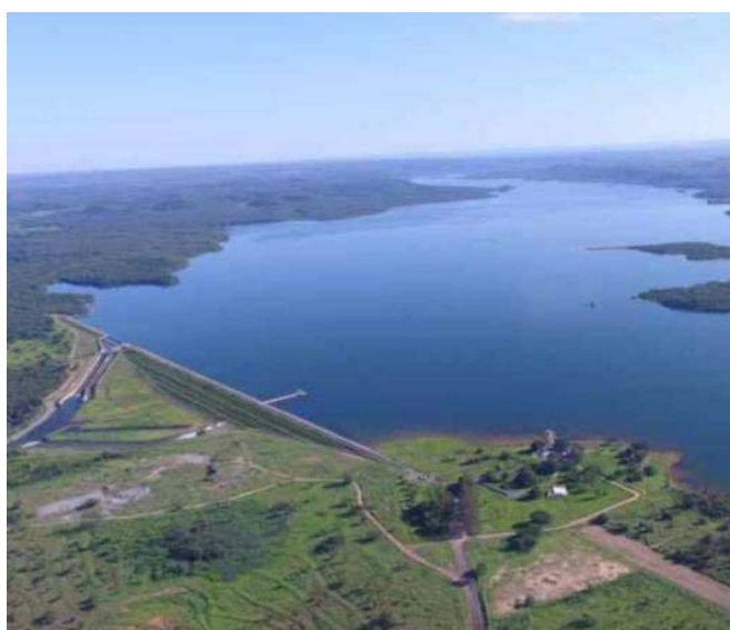
Barragem do Projeto de Irrigação Manuel Alves.
