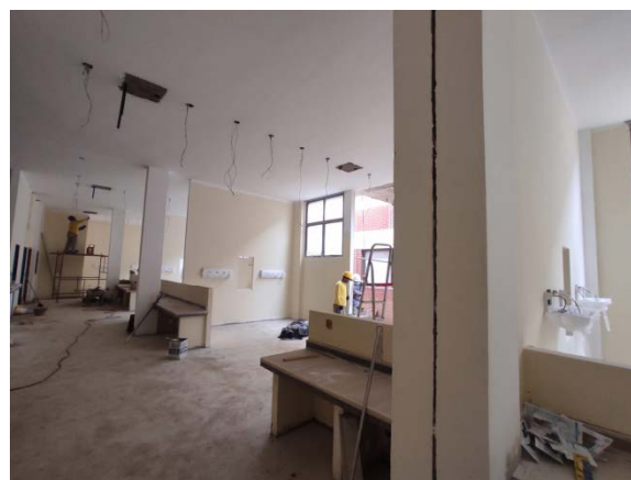
Ambiente da obra do Pronto Socorro do Hospital Geral de Palmas
