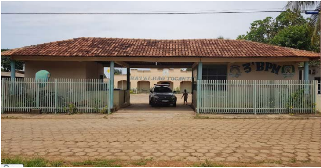
Antiga fachada do 3ºBPM
