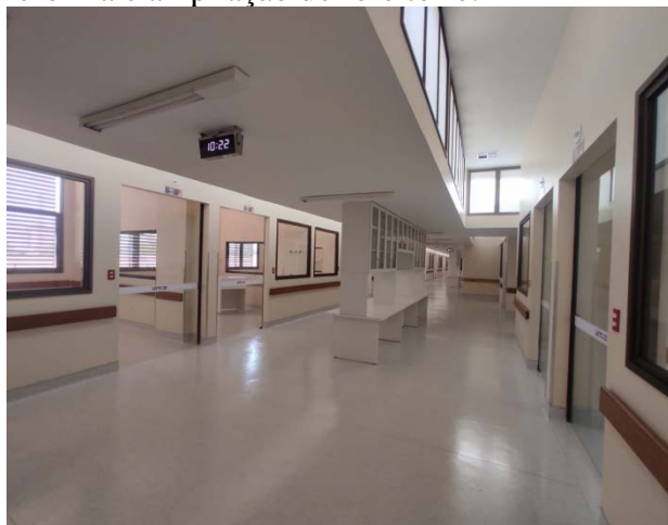
Ambiente da obra da UTI no Hospital Geral de Palmas
