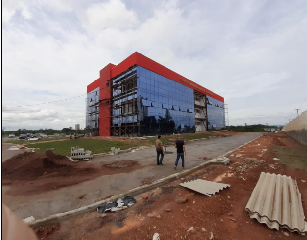
Construção do Quartel do Comando Geral do CBMTO (foto lateral de 02/12/2022).
