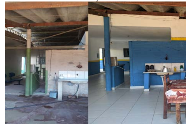
Reforma da cozinha
