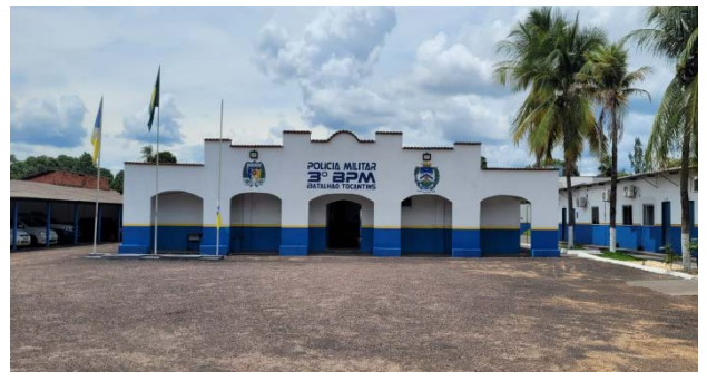
Nova fachada do prédio antigo e pátio com brita asfáltica
