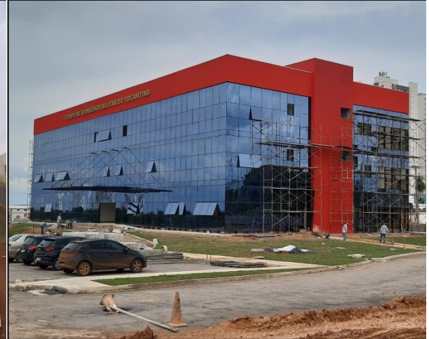
Construção do Quartel do Comando Geral do CBMTO (foto frontal de 02/12/2022).
